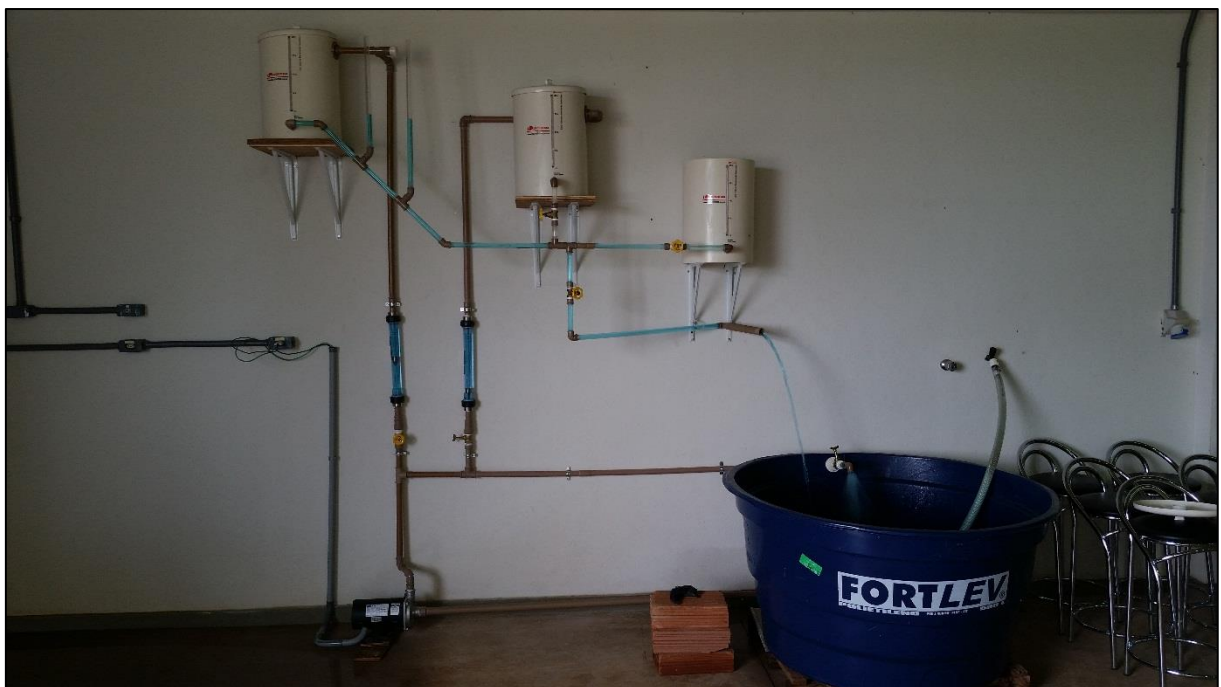
Figura 8 – Aparato experimental executado no Laboratório de Engenharia Civil
